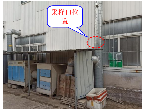
有机废气排气筒
