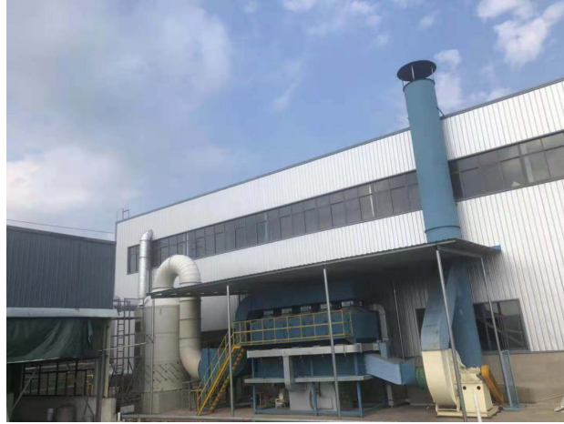
图 5 同类型“活性炭吸附脱附+RCO 催化燃烧”装置示意图
