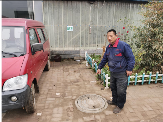
现有污水总排口规范化设置情况
