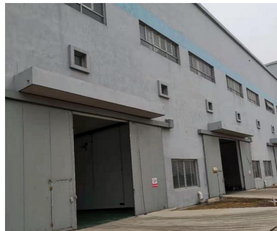
图 2.1-2 租赁联排厂房外部现状
