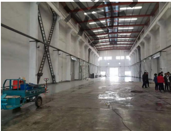
图 2.1-1 租赁联排厂房内部现状
