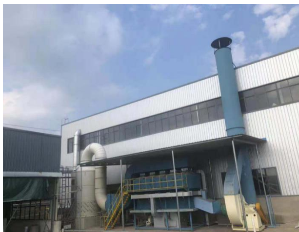
图 7.2-2 同类型“活性炭吸附+脱附+催化燃烧”装置示意图
