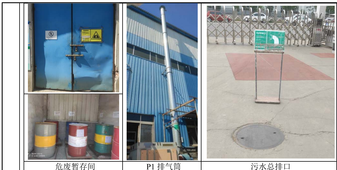
图5. 现有工程排放口规范化设置情况
